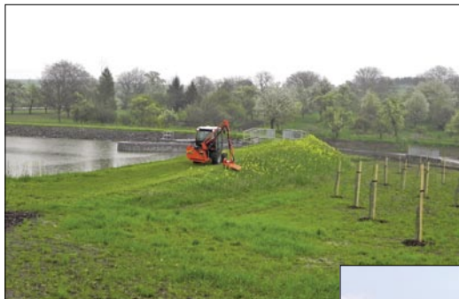
Sečení hráze obecní technikou
