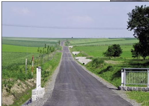
Cesta C5 - Zemanka se svodnými příkopy
